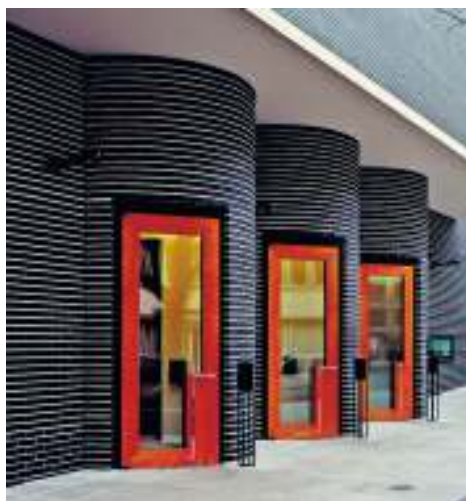
Eingangstüren des EnBW-Gebäudes
