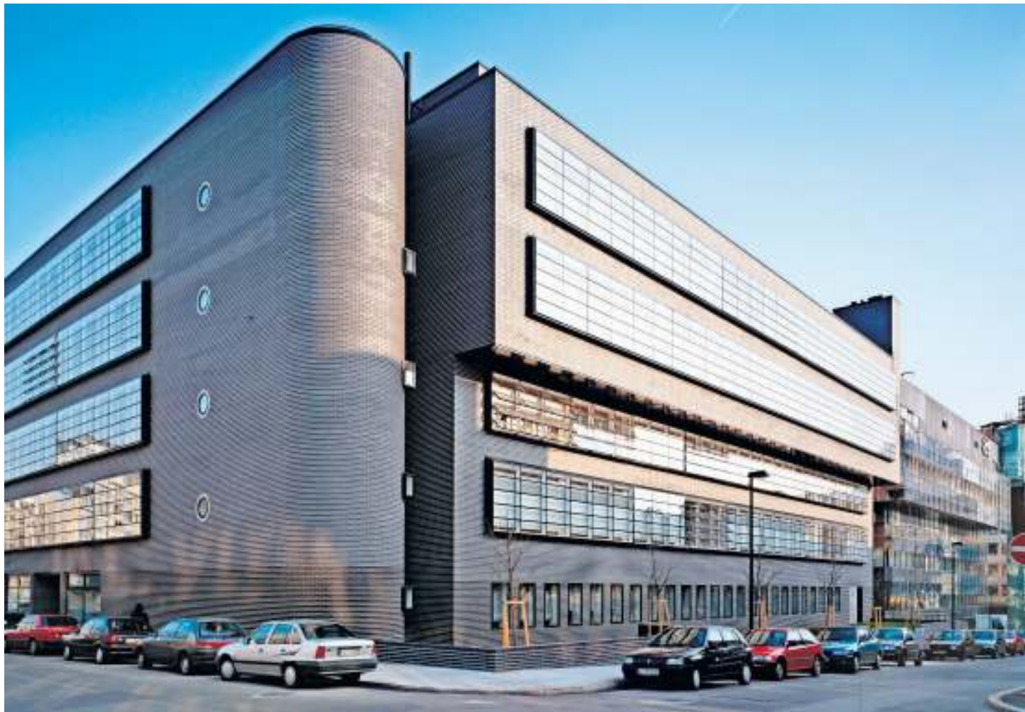
An ihr hat sich die Debatte über Abrisse in Stuttgart entzündet: die frühere EnBW-Hauptverwaltung in der Jägerstraße. Fotos: Roland Halbe
